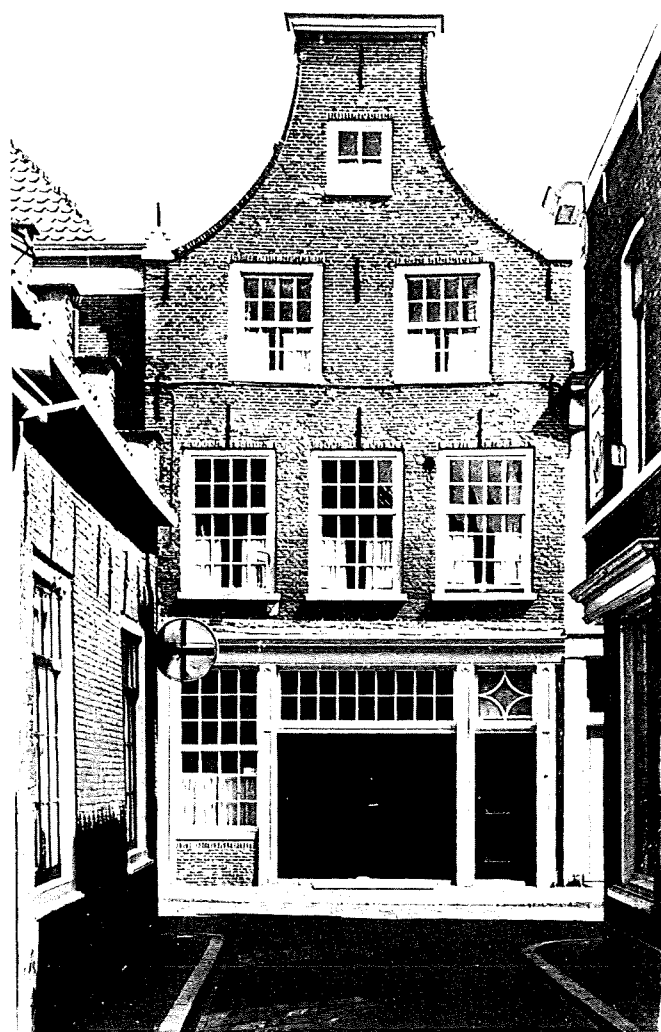
afb. 4. Klein Heiligland 53, 1959. In 1958 werd een met de harmoniërende pui aangebracht. Op de eerste verdieping we T-ramen vervaangen door schuiframen met een roedeverdelin.
